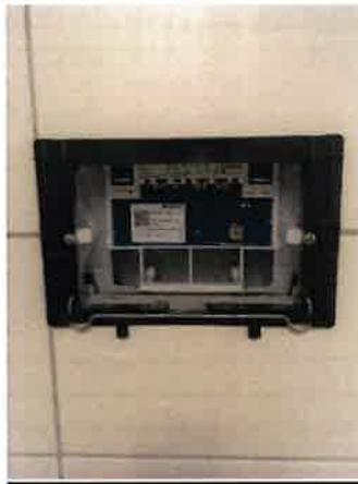
Abbildung 14: Automatische Spülstation
