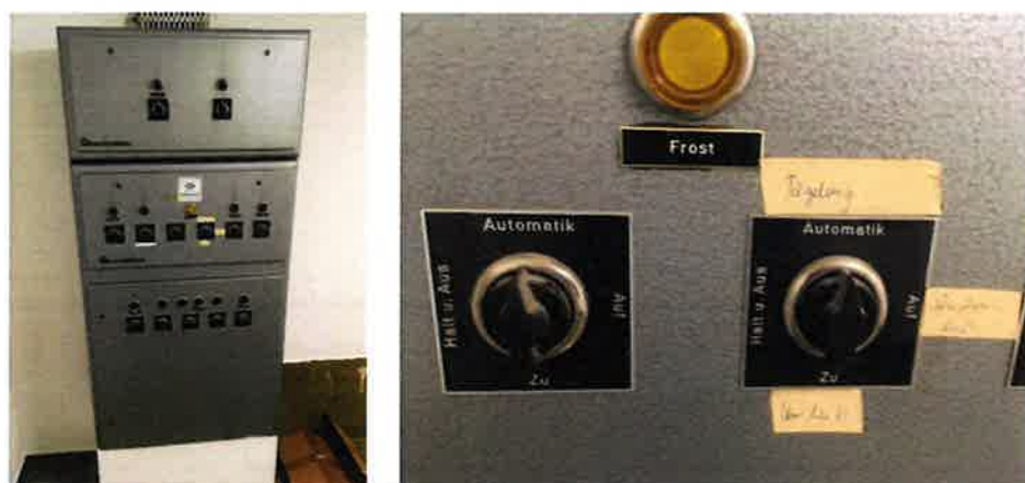
Abbildung 7: Regelungstechnik der Lüftung und Heizungstechnik
