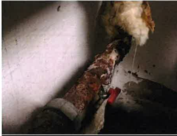
Abbildung 4: fehlender Brandschutz in der Zentrale
