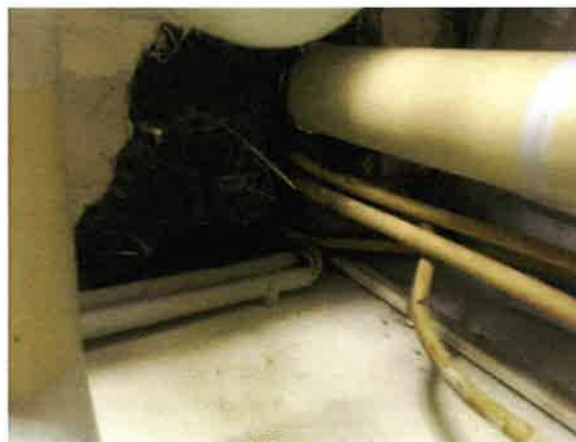
Abbildung 4: fehlender Brandschutz in der Zentrale
