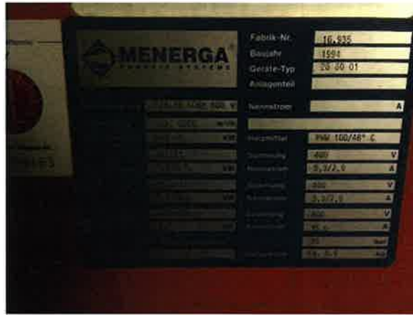
Abbildung 6: Typenschild der RLT-Anlage Schwimmbad
