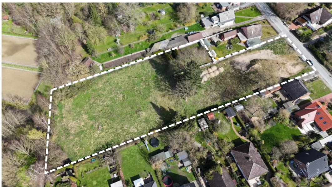
Abbildung 6 Plangebiet mit angrenzender Bestandsbebauung (04/2024)
