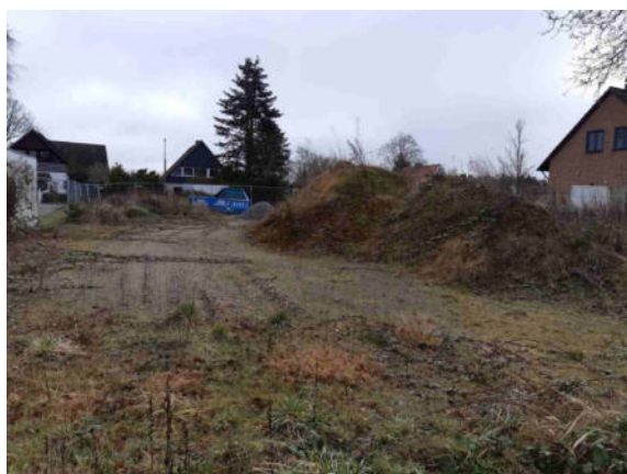
Baustelle im Osten der überplanten Fläche
