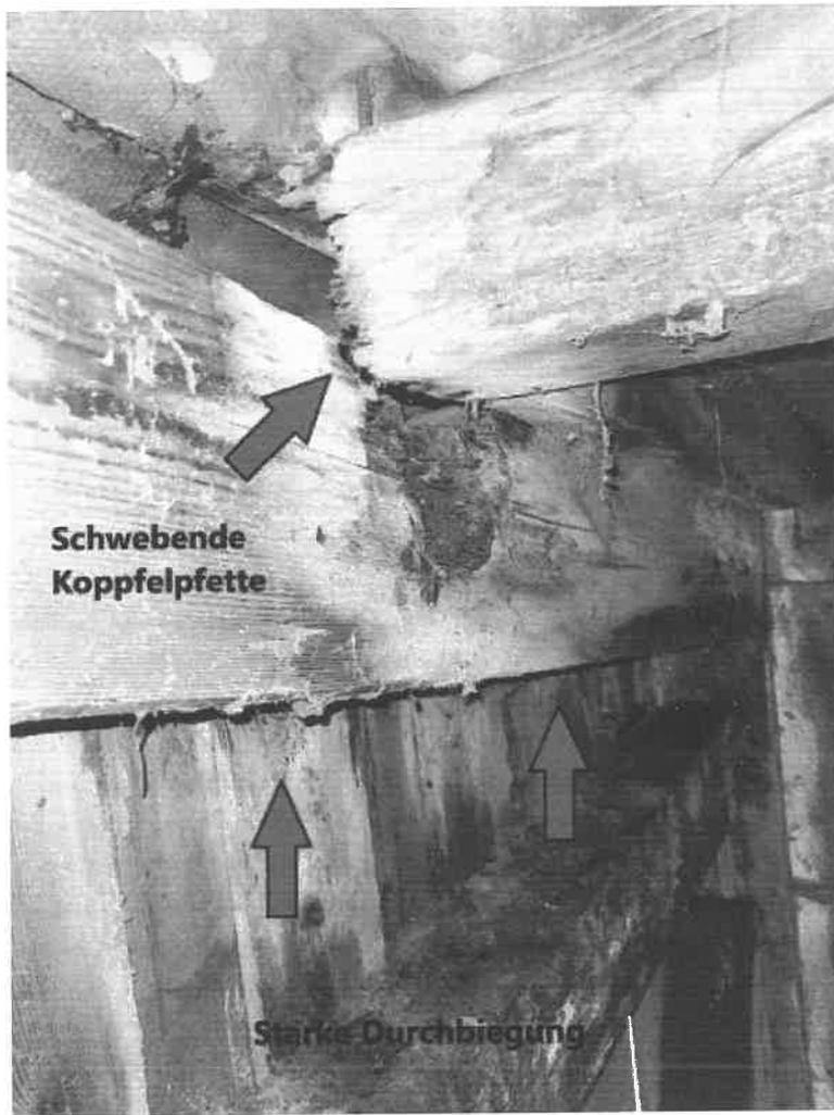
Abbildung 19: Freischwebende Koppelfette, Durchbiegung des Obergurtes, Querschnittsverluste
