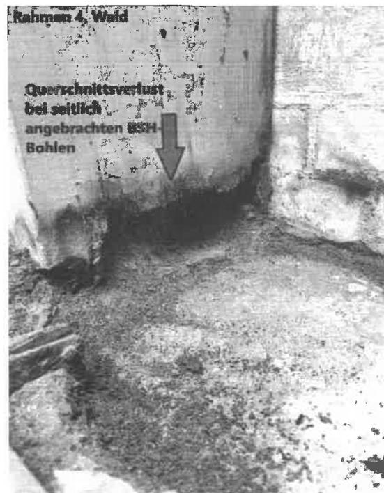
Abbildung 7: Momentanes Auflager für Binder 2, Waldseite (links). Querschnittsverlust der BSH-Bohlen (rechts)
