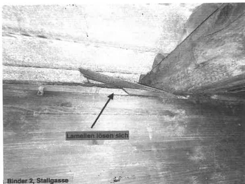
Abbildung 14: Spreizung der Lamellen
