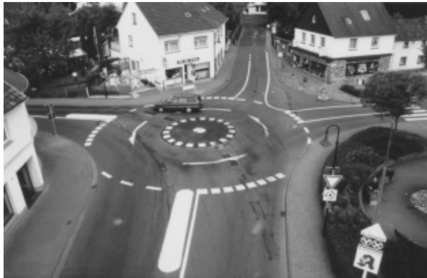
Abb. 1: Mini-Kreisel in einfacher Ausführung in Kall/Eifel (Foto: Straßenbauamt Euskirchen)
