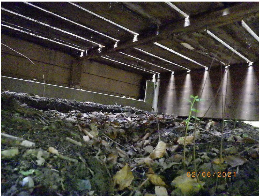
Foto Nr.: 4 – Bauwerksuntersicht – Längsträger/Auflagerbereich mit Versteifungsprofil
