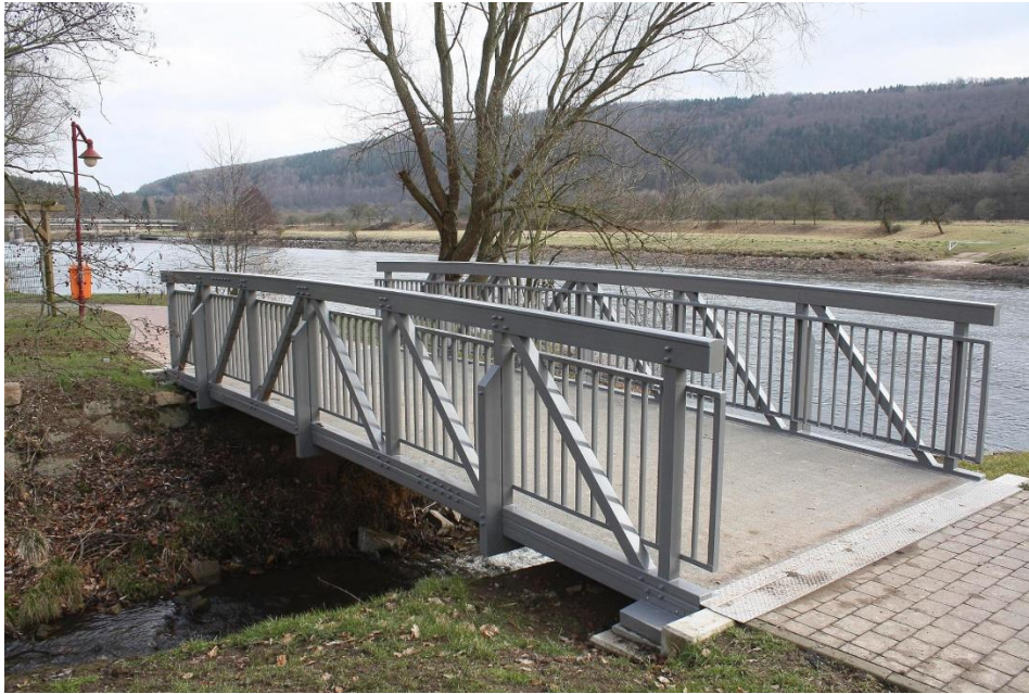
Beispielfoto GFK-Systembrücke mit Fachwerkaussteifung
