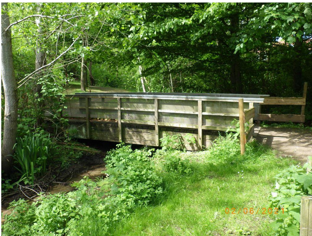
Foto Nr.: 1 - Seitenansicht
