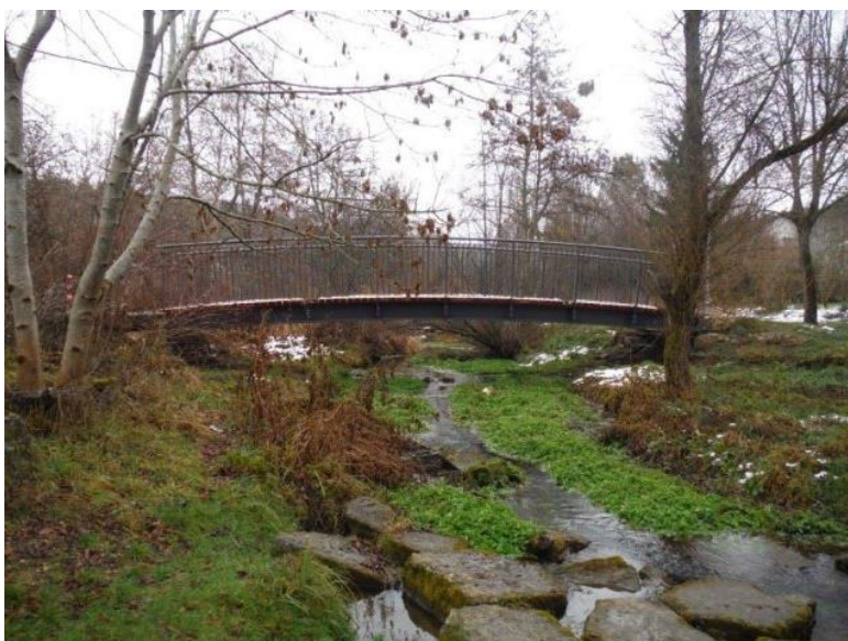
Beispielfotos Stahlüberbau über vorh. Bachlauf
