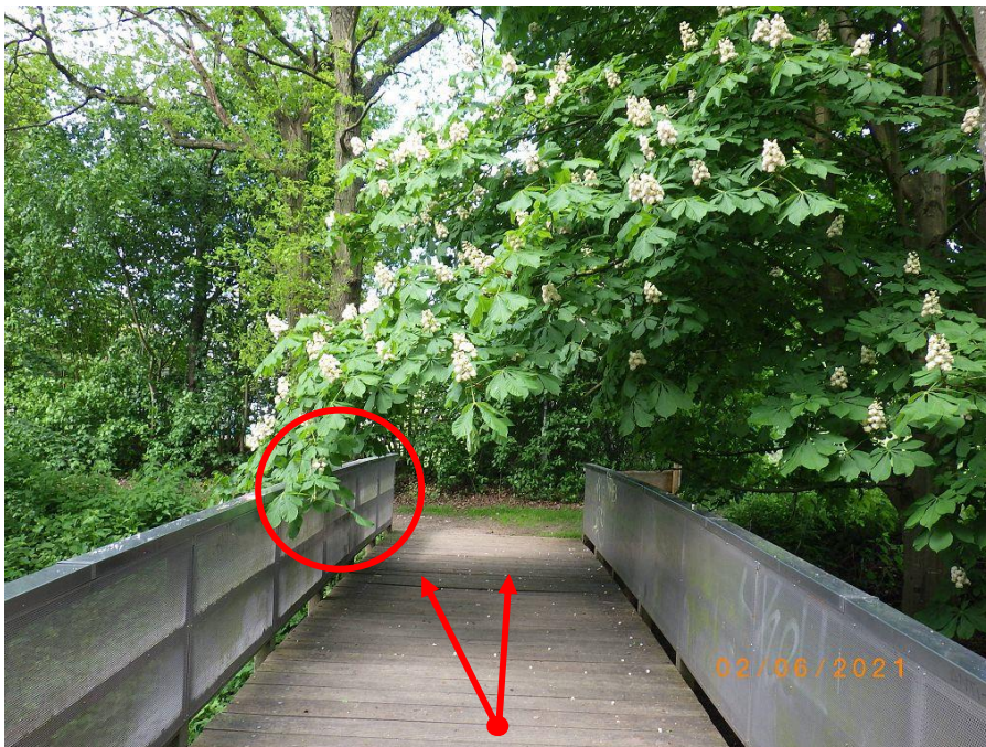
Anzupassender Baumbestand im Bereich des Widerlagers
