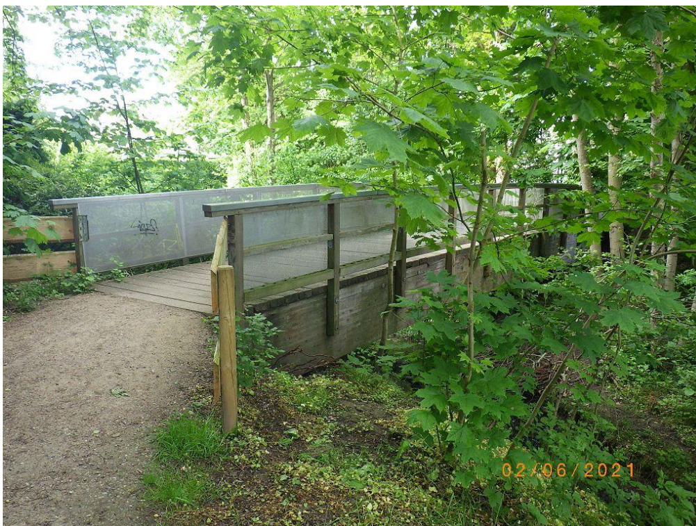
Foto Nr.: 1 - Seitenansicht
