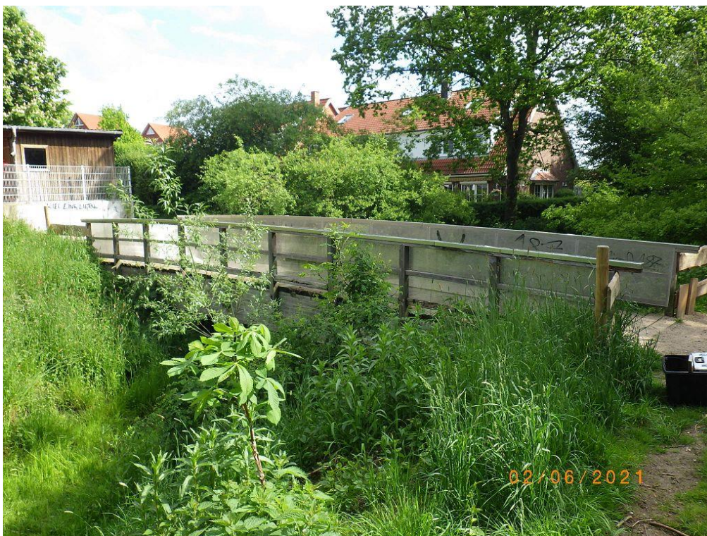
Foto Nr.: 1 - Seitenansicht
