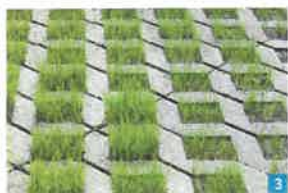
Durchlässige Pflasterung fördert die Versickerung
