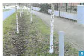
Kombination von Bäumen und Versickerungsmulden
