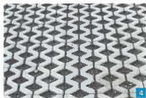
Durchlässige Pflasterung fördert die Versickerung
