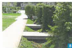
Oberflächige Ableitung über Rinnen und Mulden
