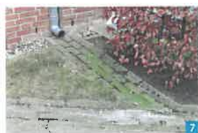
Oberflächige Ableitung über Rinnen und Mulden
