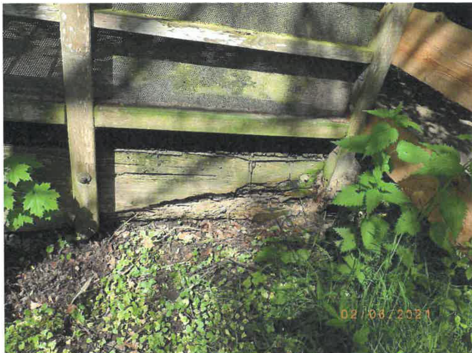
Foto Nr.: 5 – Schädigung im Auflagerbereich
