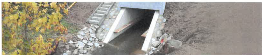
Beispielfoto Stahlbetondurchlass
