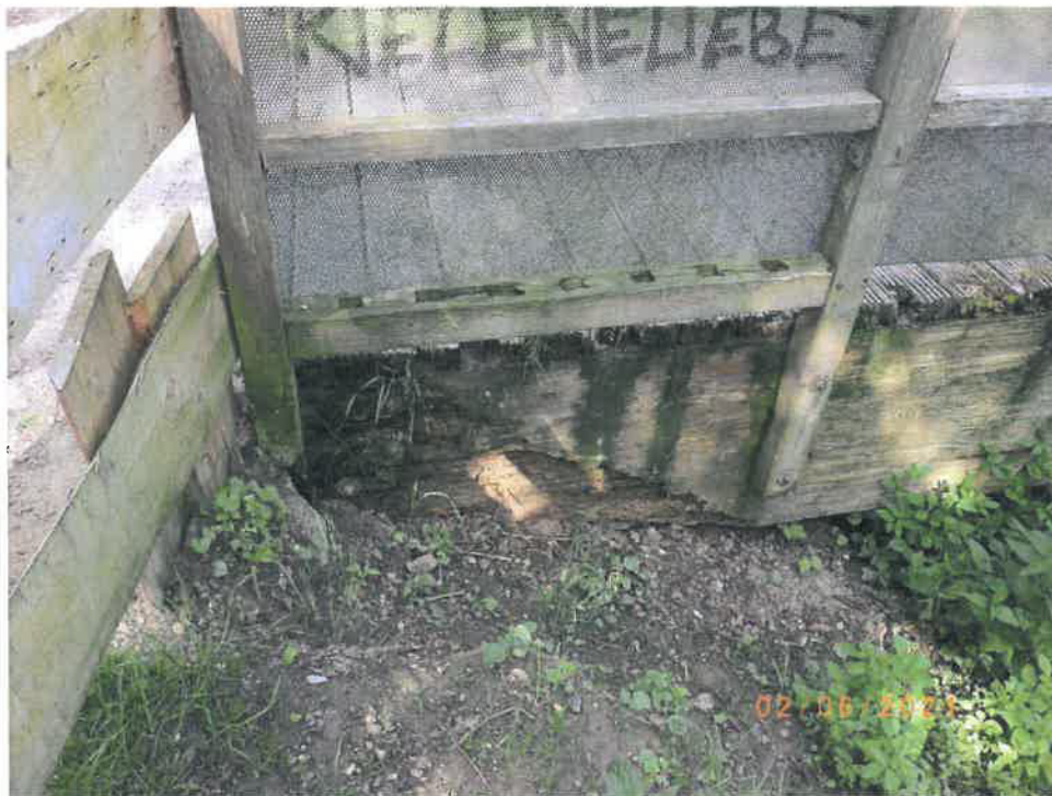
Foto Nr.: 5 – Schädigung im Auflagerbereich
