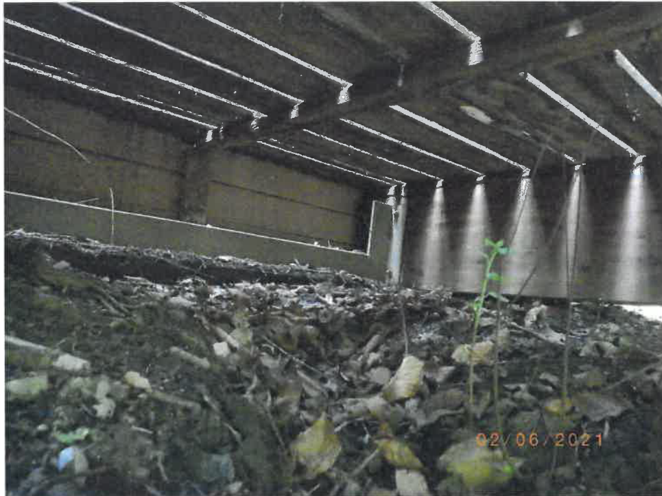
Foto Nr.: 4 – Bauwerksuntersicht – Längsträger/Auflagerbereich mit Versteifungsprofil
