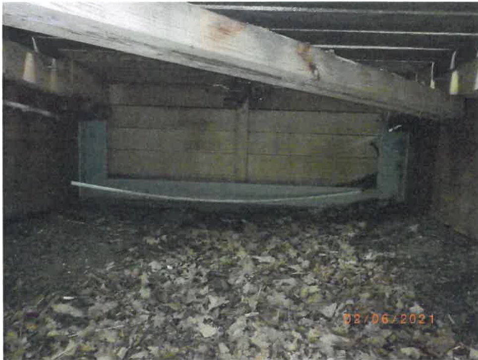
Foto Nr.: 4 – Bauwerksuntersicht – Längsträger/Auflagerbereich mit Versteifungsprofil + Diagonalstreben
