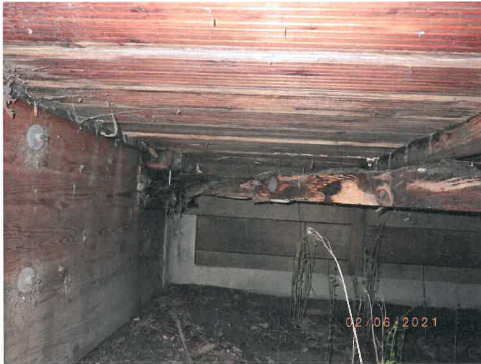
Foto Nr.: 4 – Bauwerksuntersicht – Längsträger/Auflagerbereich mit Versteifungsprofil + Diagonalverband
