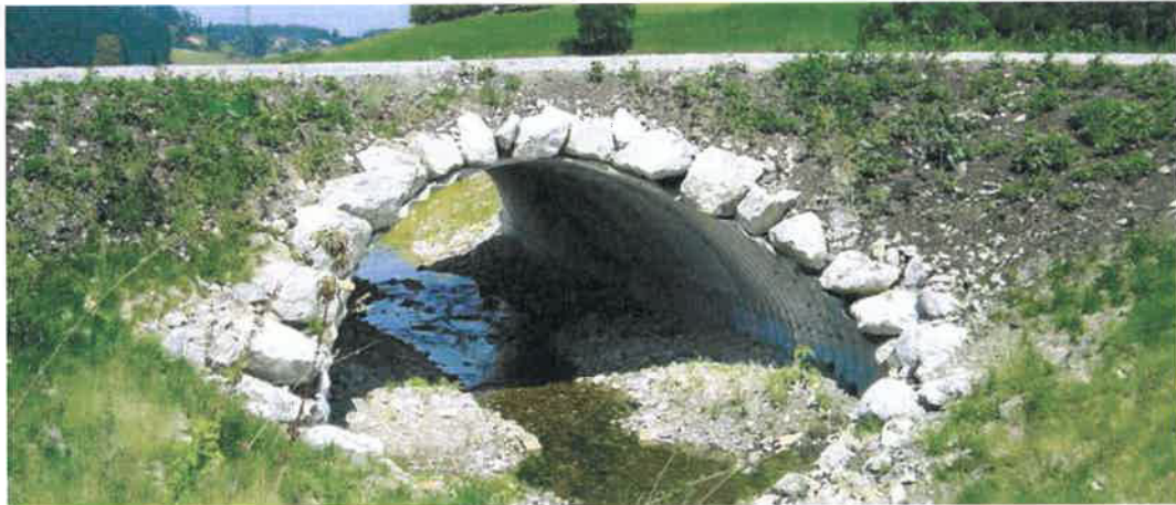
Beispielfoto Wellstahlrohr
