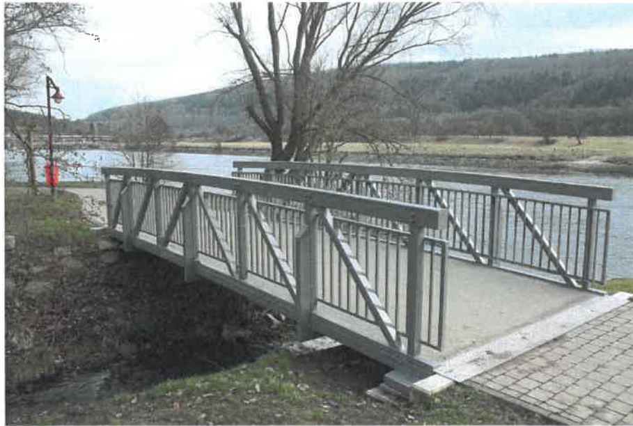
Beispielfoto GFK-Systembrücke mit Fachwerkaussteifung
