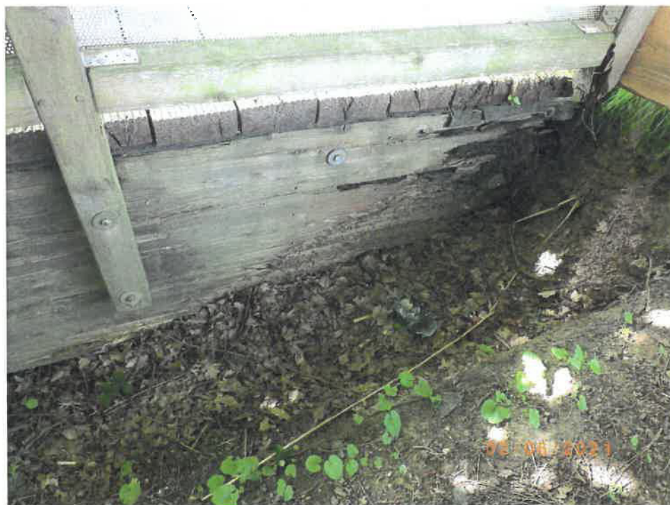
Foto Nr.: 5 – Schädigung im Auflagerbereich
