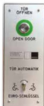
Tür-Öffner mit Euro-Schlüssel-Schließung
