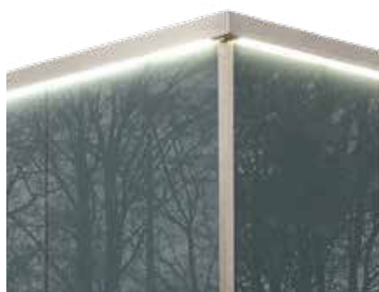
Außenbeleuchtung unterhalb der Attika
